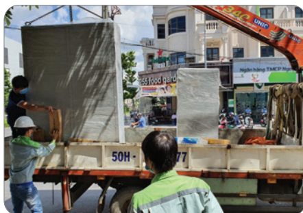
Vận chuyển tủ điện đến nhà máy để lắp đặt.
